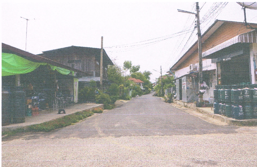
เทพื้นแอสฟัลติกอนกรีตถนนเมืองฮาม
